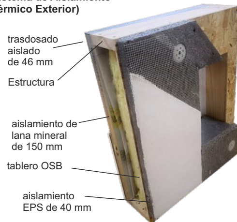
Muro exterior de 30 cm de grosor con SATE (Sistema de Aislamiento Térmico Exterior)
